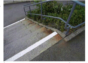
ÖVERSTA OCH NEDERSTA STEGET I NYA TRAPPOR OCH BÖRJAN OCH SLUTET PÅ NYA RAMPER MARKERAS MED 100 MM VIT VÄDERBESTÄNDIG FÄRG.
